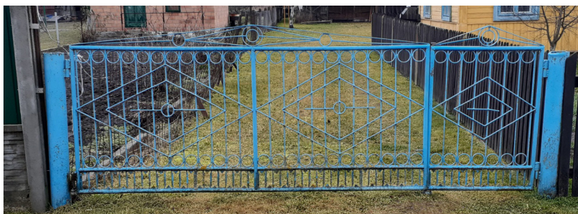
Рисунок 15 – Комбинация ромбовидных элементов с окружностями и прямыми линиями. Материал: металлические балки, трубы, арматура. Место расположения – г. Жабинка
