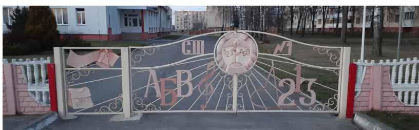
Рисунок 32 – Материал: арматура, трубы, металлические балки, жестяные листы
