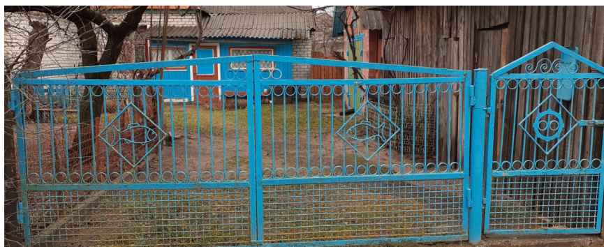
Рисунок 27 – Материал: сетка из толстой проволоки, арматура, трубы, металлические балки. Место расположения – г. Жабинка
