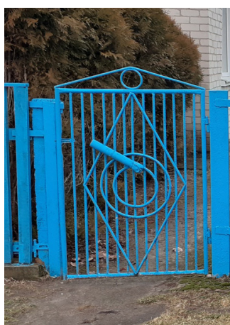
Рисунок 13 – Оформление калитки с применением ромбовидного символа, позаимствованного из деревянного народного декора. Материал: арматура, трубы. Место расположения – г. Жабинка
