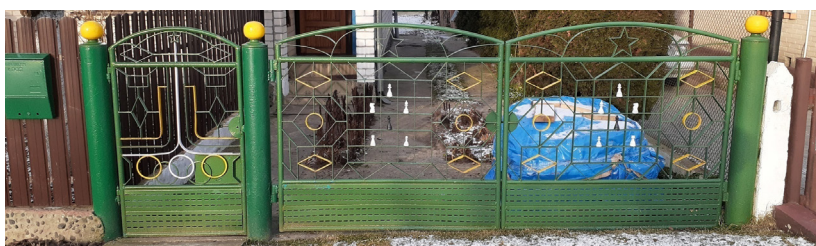
Рисунок 31 – Материал: арматура, трубы, фрагменты зерноочистительного сепаратора. Место расположения – г. Жабинка
