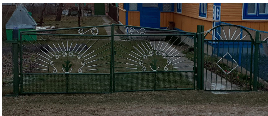
Рисунок 28 – Материал: сетка из толстой проволоки, арматура, трубы, жестяной лист. Место расположения – г. Жабинка
